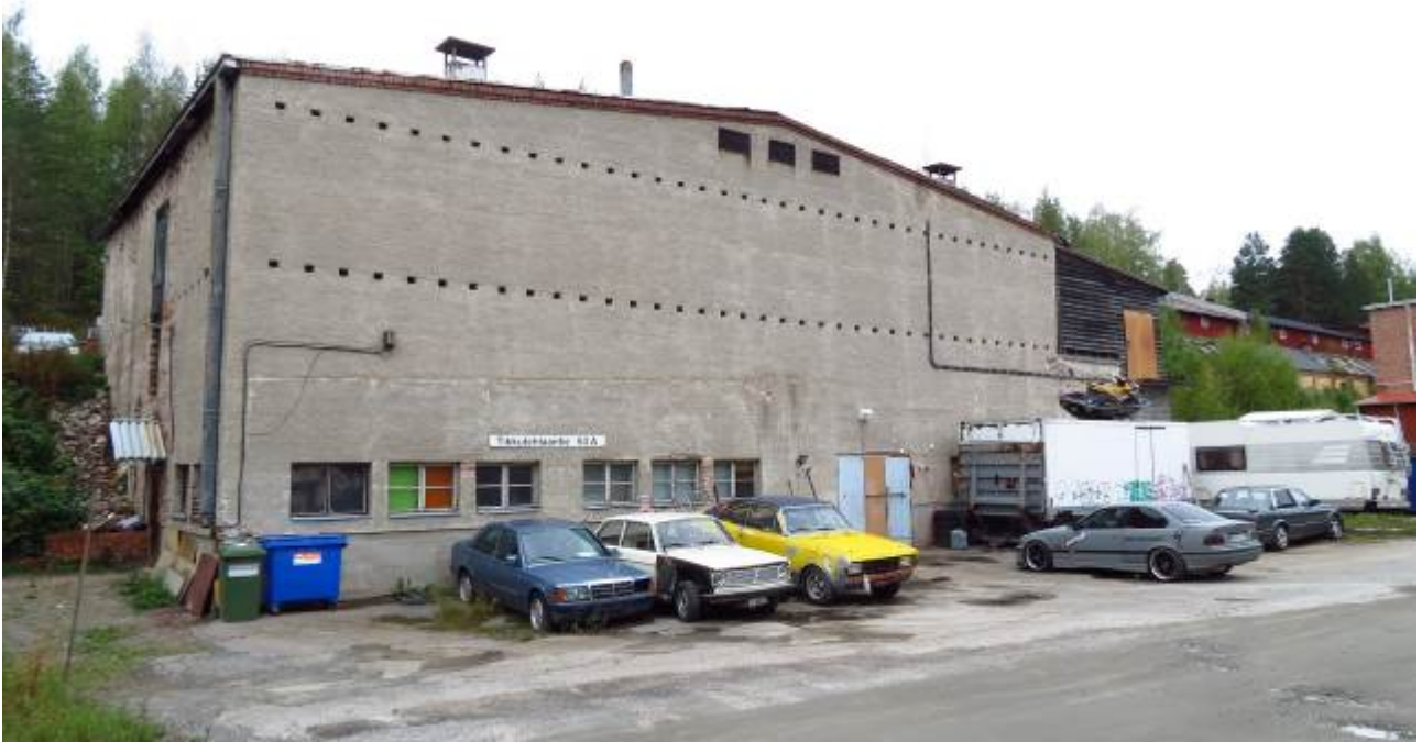
Kuva 10. Tikkutehtaantie 63A rakennettiin alunperin monikerroksiseksi puutavaran kuivaamoksi.
