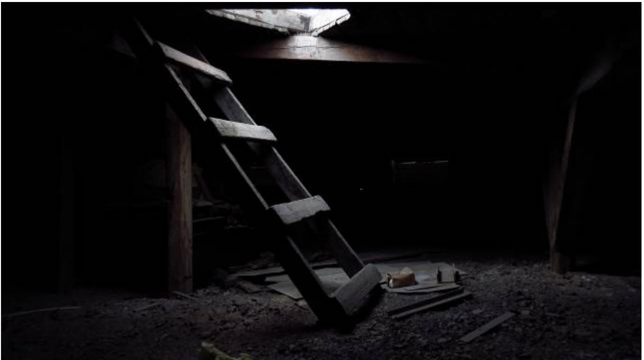
Kuva 11. Näkymä Tikkutehtaantie 63A:n ullakolta. Tilan pintoja peittää valtaosin tummanharmaa noki ja tummat hiilimäiset palaset.
