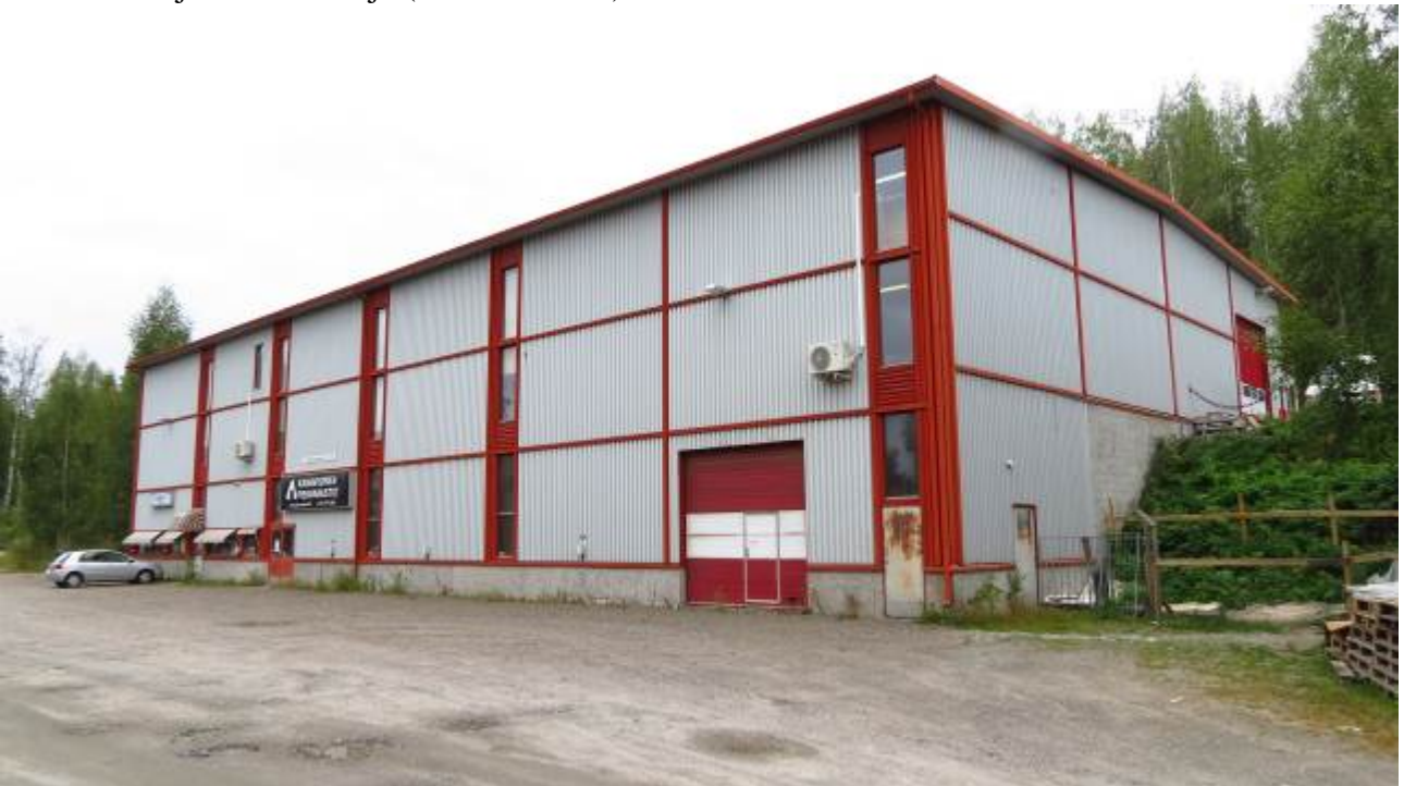
Kuva 13. Tikkutehtaantie 63B on tutkimuskohteista kaikkein tuorein ja myös rakenteeltaan tiivein.
