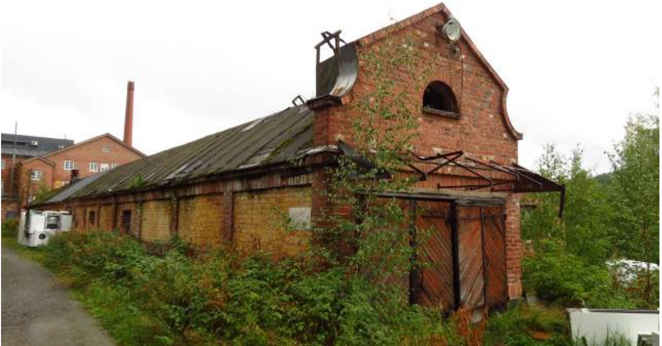
Kuva 4. Varassaaren Vanha kuivaamo lounaasta kuvattuna. Pohjoispäätä lukuunottamatta rakennus on tiiliverhottu
