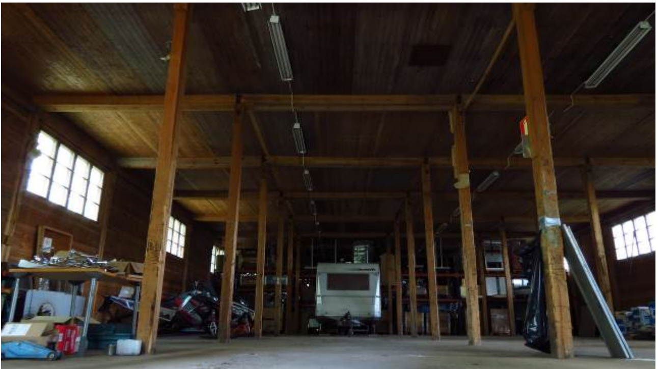
Kuva 3. Näkymä Länsihallin eteläpään ovelta kohti pohjoispuolen hyllykkövälineitä ja liiketiloja.
