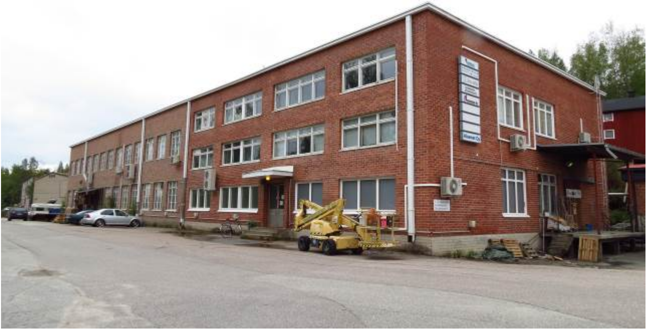
Kuva 8. Tikkutehtaantie 4:n yritys- ja pienteollisuustalo pohjoisesta päin kuvattuna.
