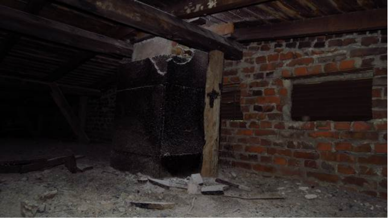
Kuva 12. Tikkutehtaantie 63A:n ullakon rakennetta ja lattiapintaa.
