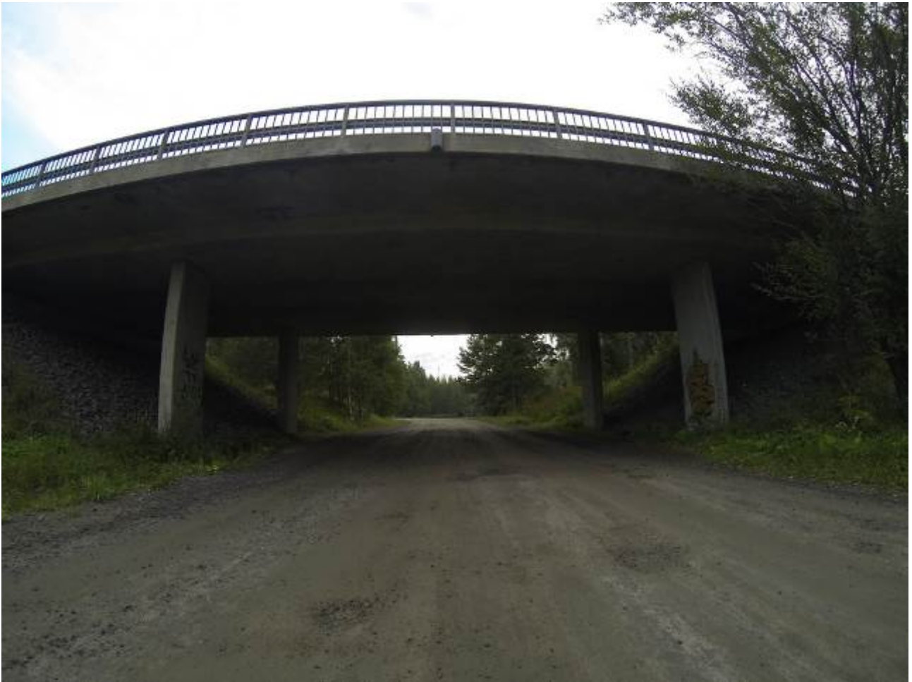
Kuva 1.2. Valtatie 4:n Vaajavirran puoleinen tunneliaukko, jonka molemmille reunoille sijoitettiin detektoriyksikkö.
