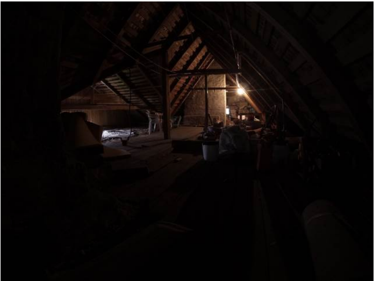
Kuva 2.3. Poikalanmäki 110:n ullakonäkymä. Kaikkien Poikalanmäen rakennusten ullakot olivat melkein identtisiä.
