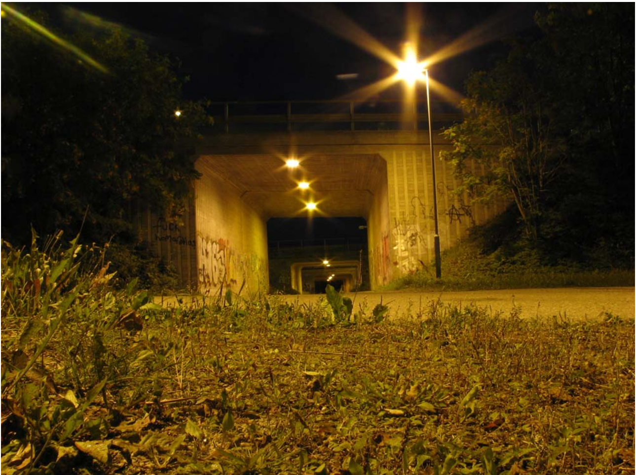
Kuva 1. Hannikaisenkadun, ratalinjan sekä Rantaväylän alikulku Olutryvinkujalta kuvattuna.
