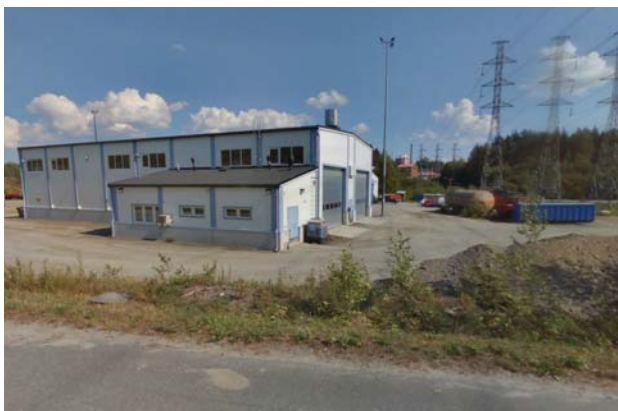
KUVA 7 Tontin eteläosassa sijaitseva Fingridin 110 kV:n voimalinja. Rakennukset sijoittuvat kiinni voimalinjan vaara-alueeseen (v).
